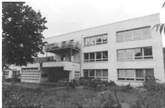
幼稚園舎のリノベーションによる20世帯の多世代型共同住宅
